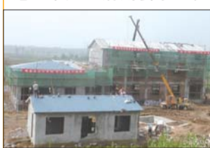
施工中的玉清湖引水工程
