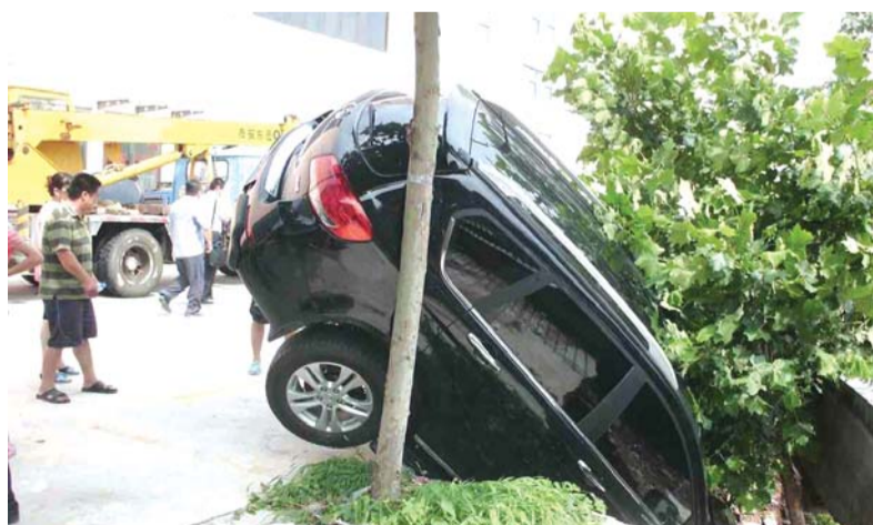
停车位下被雨水冲刷导致塌陷,停在上面的轿车一头栽了下去。 本报记者 刘来 摄
