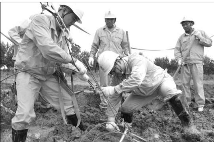
16日,阳信县供电公司紧急抢修因暴雨造成倾斜的35千伏涝水线75号杆。阳信县自7月9日开始出现强降雨过程,造成当地电力线路遭受不同程度倾斜,极易发生断杆停电事故。阳信电力立即启动应急预案,组织人员开展特巡及维护,确保全县群众用电可靠。
