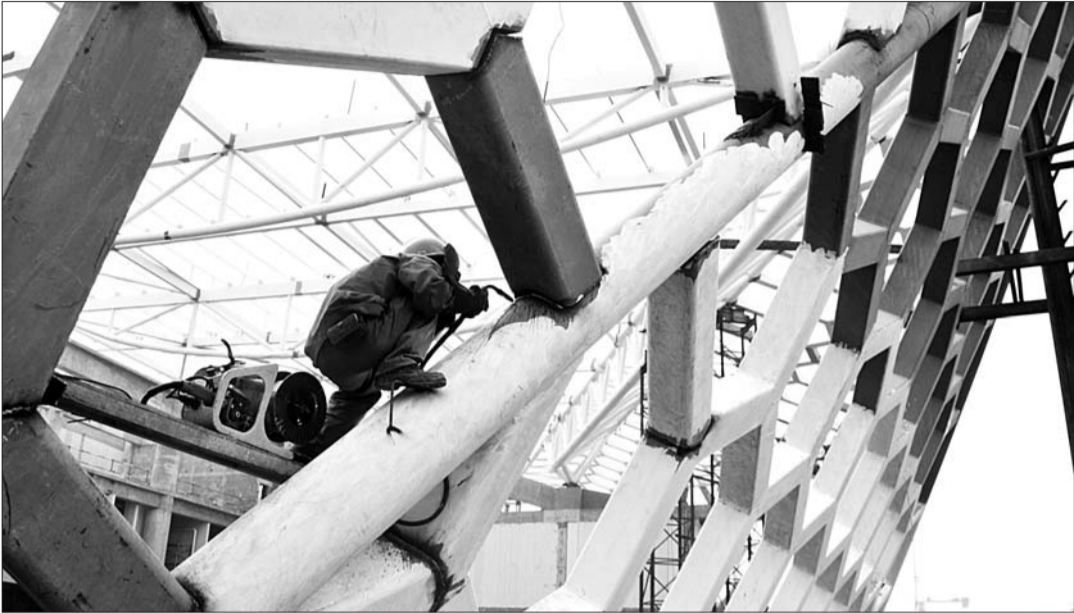
工人正在焊接游泳馆的外墙。本报记者 李岩松 摄
