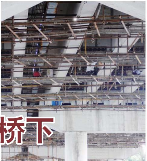
7月17日,在大学路岔河桥,连日降雨过后,工作人员恢复对桥梁的加固施工,桥下横隔板的粘贴钢板加固工作已完成近半,桥面加固维修也在紧张进行中。
