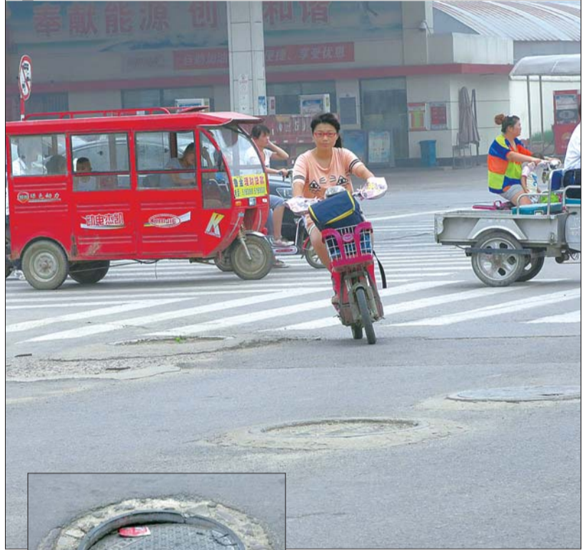
▲一市民绕开路上的井盖。 ▲由于后续摆放工作不合理,部分井盖边缘已被过往车辆轧坏,如遇暴雨来临,很容易被污水顶起。
