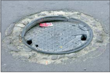
▲一市民绕开路上的井盖。 ▲由于后续摆放工作不合理,部分井盖边缘已被过往车辆轧坏,如遇暴雨来临,很容易被污水顶起。
