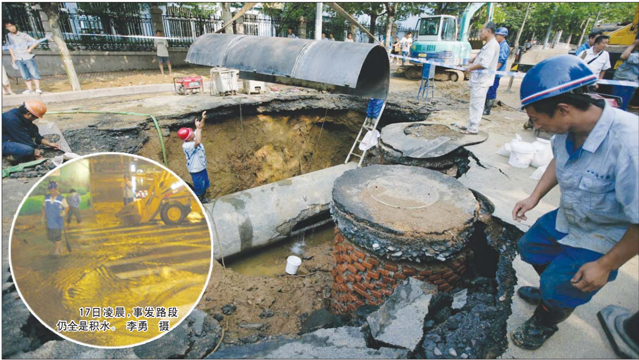
工作人员正在抢修破裂管道。张晓鹏 摄
