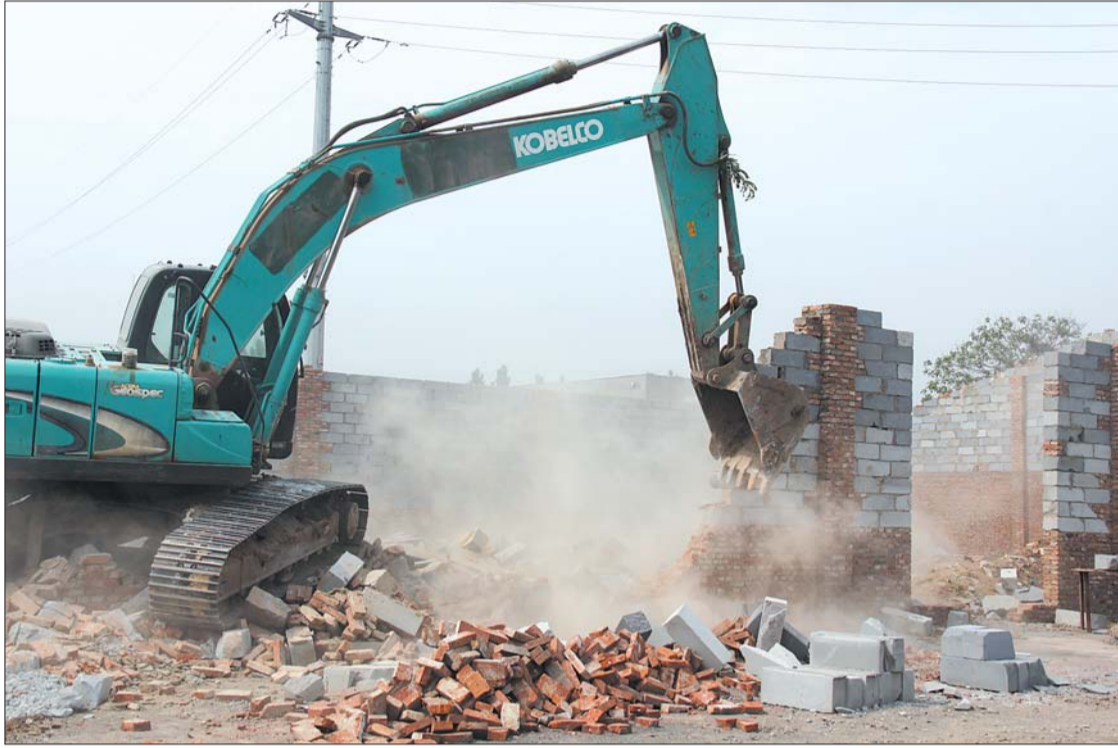
18日,历城区对华山片区内六处违法违规建筑进行强拆。通讯员 赵强 摄
