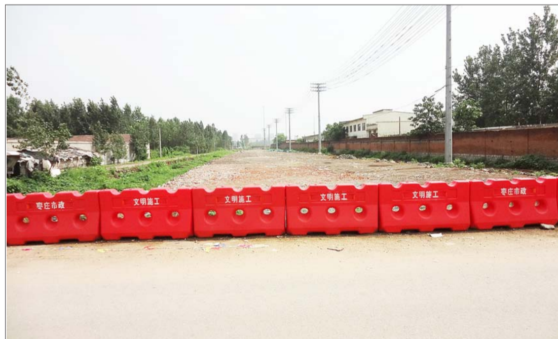
建设南路道路工程目前正封闭施工。本报见习记者 刘近岐 摄
