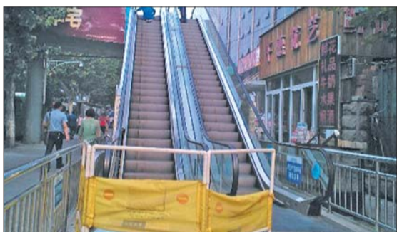
中心医院过街天桥电梯正在检修。 本报记者 喻雯 摄
