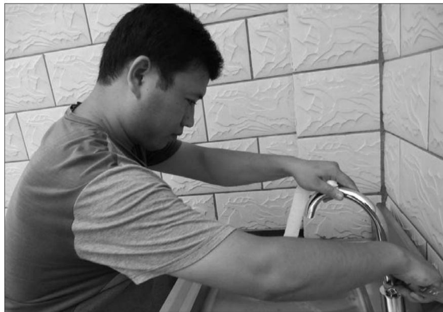
工作人员正在进行直饮水设备调试。
