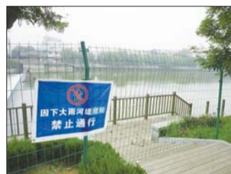
防护网已安装完毕。本报记者 殷悦 摄
