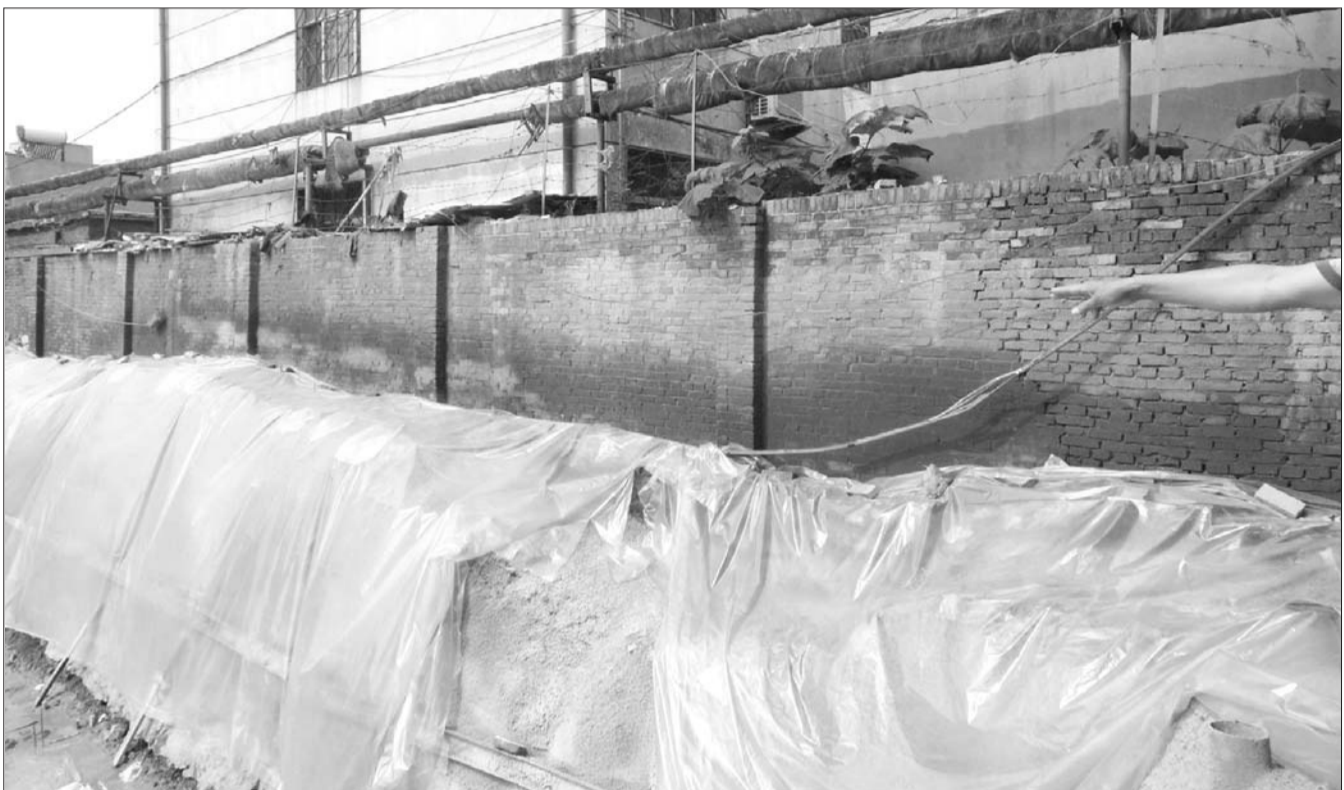
楼外不到两米,即是在挖的地基坑。本报记者 任洪忠 摄
