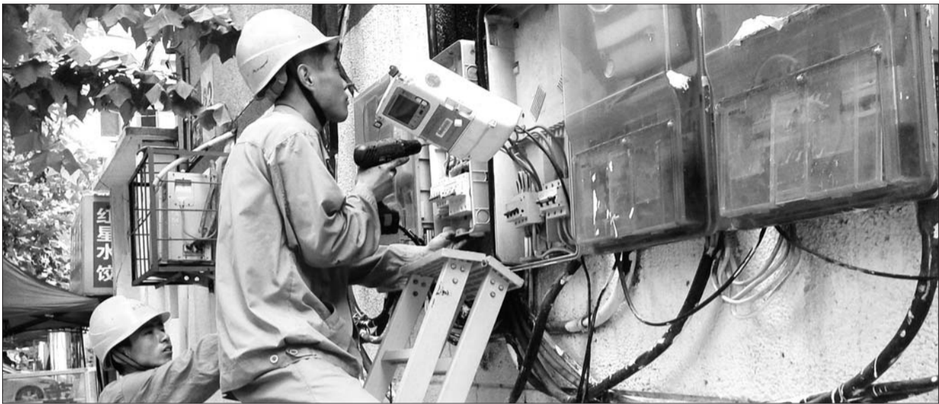
供电抢修队员在进行抢修。本报记者 范少伟 摄
