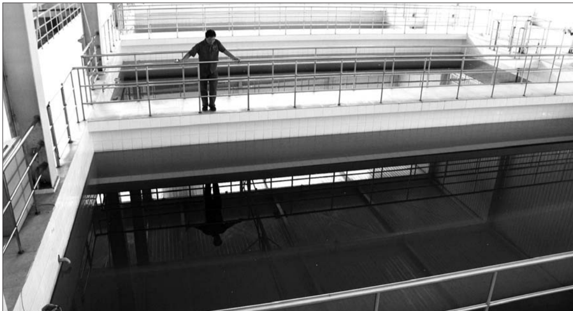
通过第一道沉淀,原水实现了初步净化。本报见习记者 韩逸 摄
