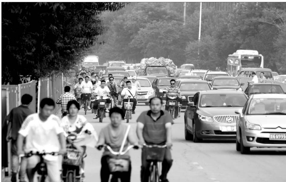
24日,天衢路北侧非机动车道铺设管道施工,相邻两侧道路都因施工封闭,高峰时段道路交通压力陡然增大。 本报记者 马志勇 摄
