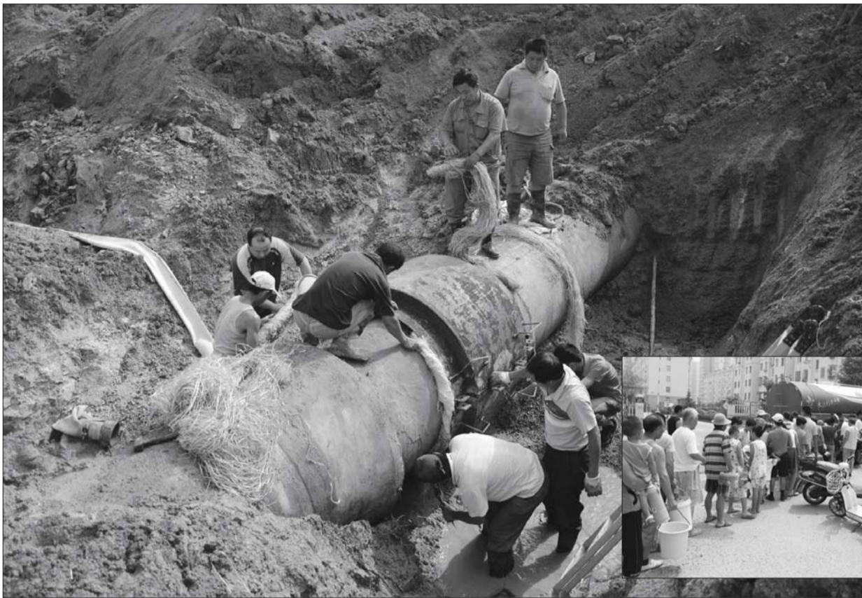
工作人员正在抢修损坏的管道。潘旭业 摄
