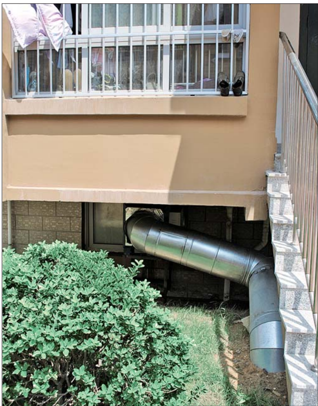
▲任家东侧邻居家阳台下,蜿蜒着一段白铁烟囱。 记者 吕修全 摄
