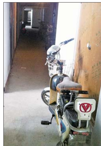
有业主把电动车直接放在地下室走廊,十分影响通行。 本报记者 张召旭 摄
