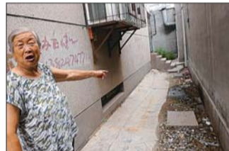
楼上居民认为,是因为盖了这些房子,致使原有的泄洪道路被堵,造成了地下室被淹。
