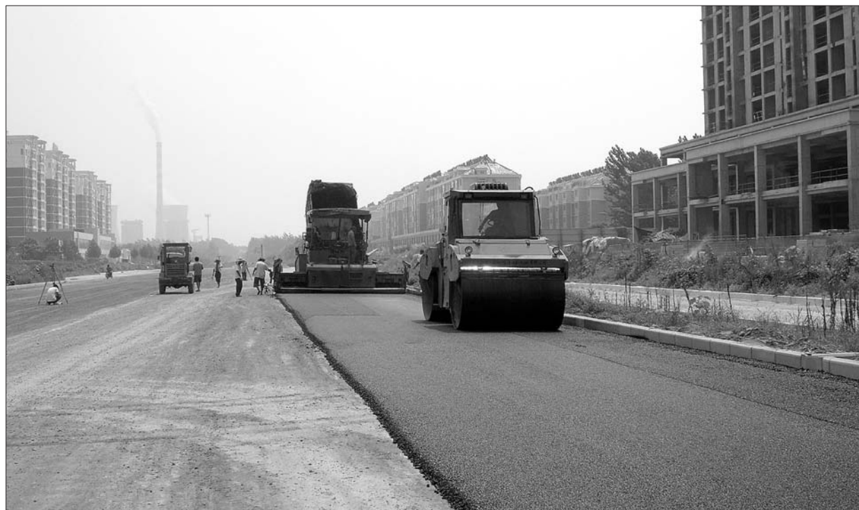
路面上正在铺沥青。 本报记者 张建丽 摄
