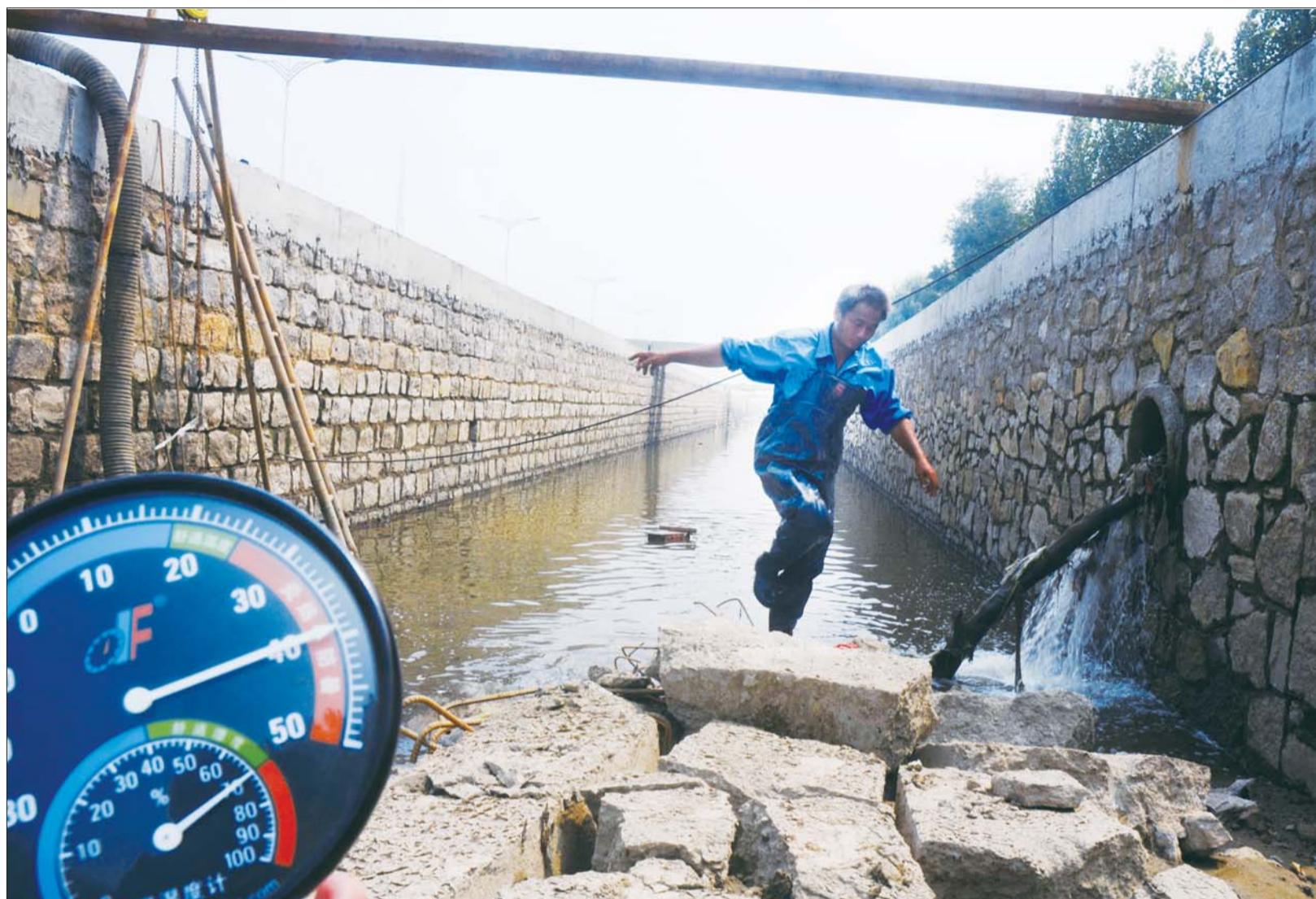
7月31日14时30分许, 在德州东沟泄洪沟改造施工现场, 温度接近40℃, 湿度接近70%。 本报记者 马志勇 摄
