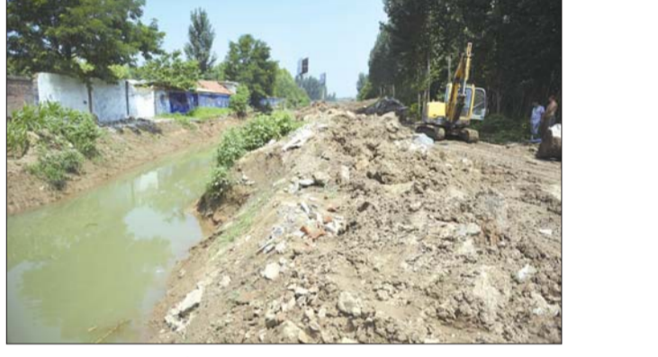
▲正在施工的杨家河。
