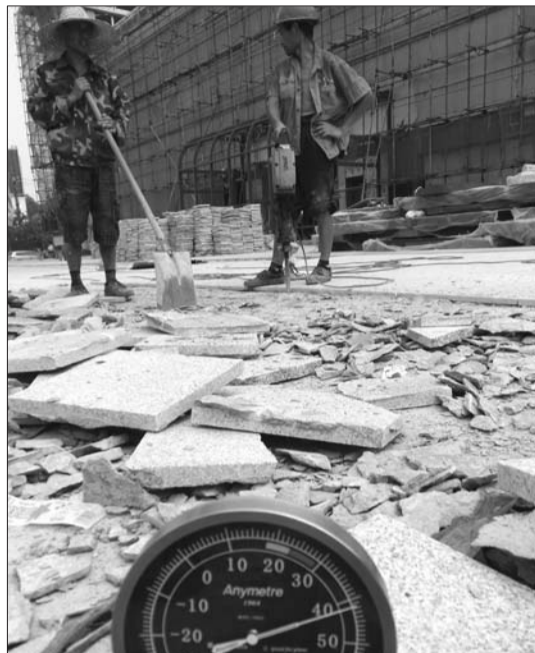
来自云南昆明的何万民和江苏南通的知大明正在使用风枪拆除地板砖,重新修整一块空地的地面。
