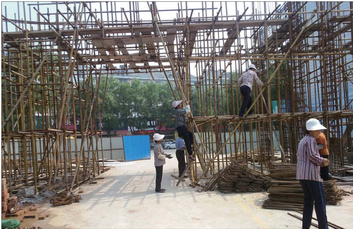
7月31日,莱芜城区温度达到33摄氏度。高温下,莱芜实验学校工地上的工人依然忙碌在脚手架上,坚持工作,然而他们却领不到相应的高温津贴。 见习记者 徐莹 摄
