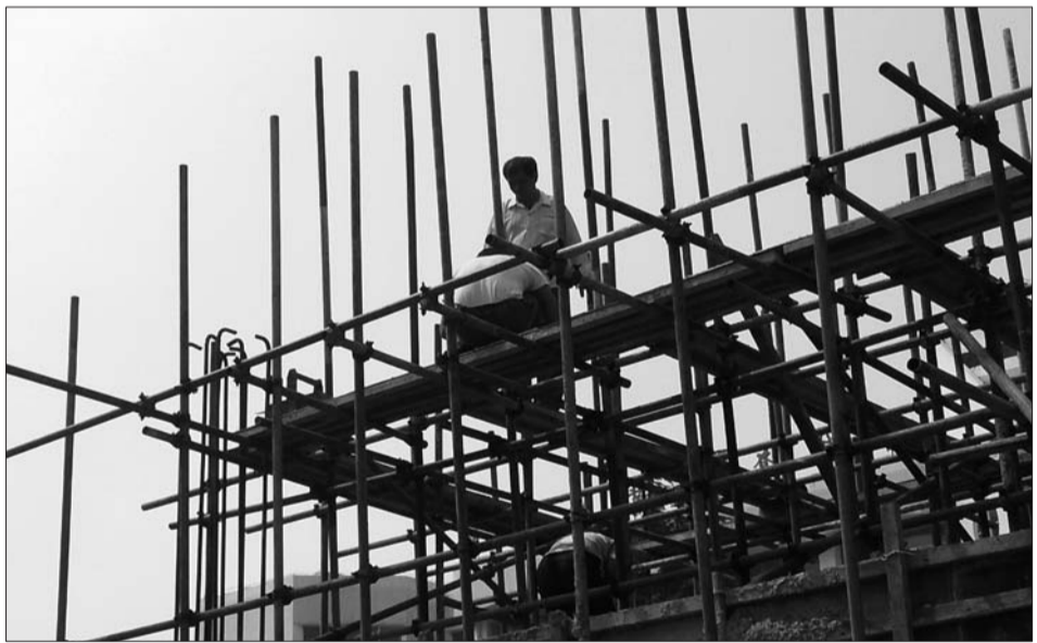
▲工人正在莱芜实验学校工地施工。
