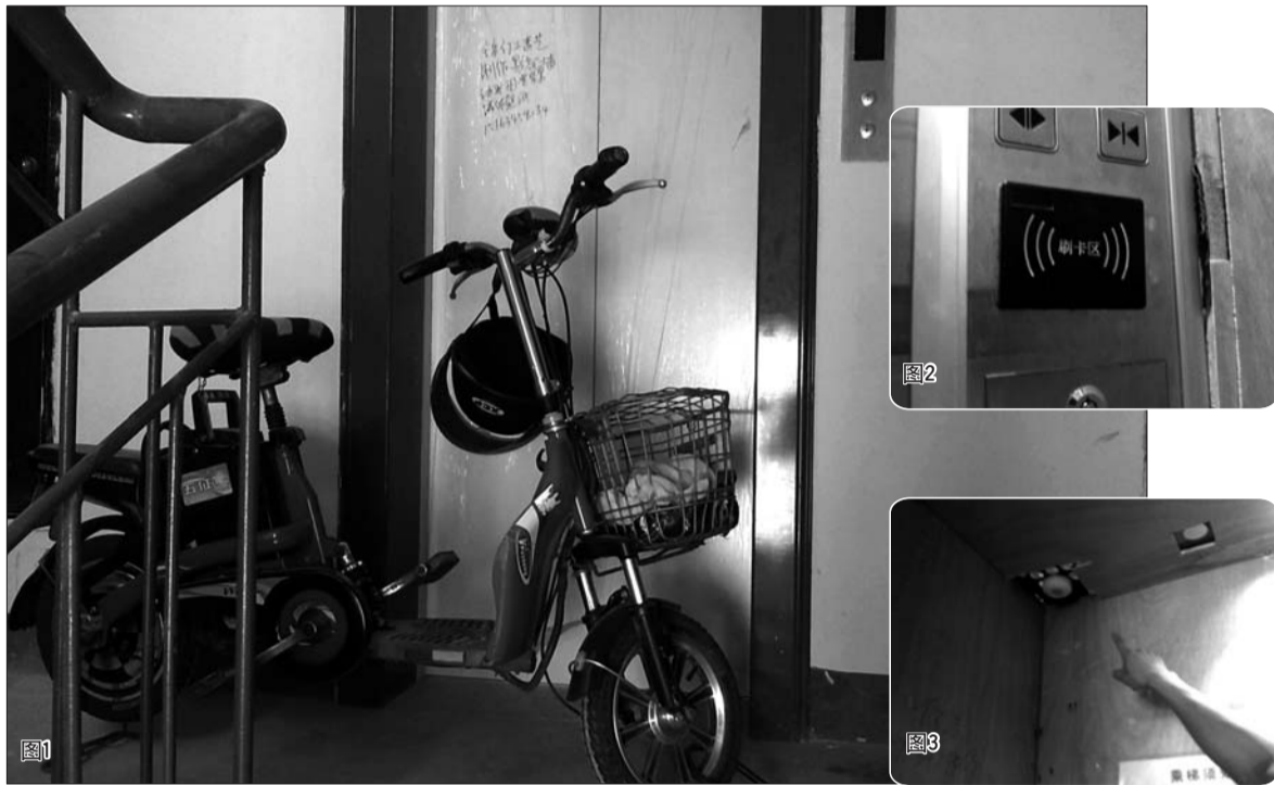
图1:电梯停用一周了，居民把在一辆电动车停在了电梯口。图2:电梯内的刷卡区。图3:正常运行的电梯中的感应器，居民在刷卡区刷卡后，感应器收到指令，居民才能选择楼层。
