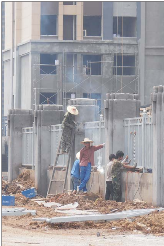
顶烈日施工。本报见习记者 贾晓雪 摄
