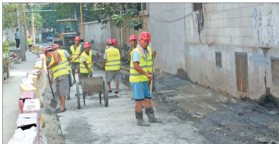
▲昆仑街小区截污工程扫尾。
