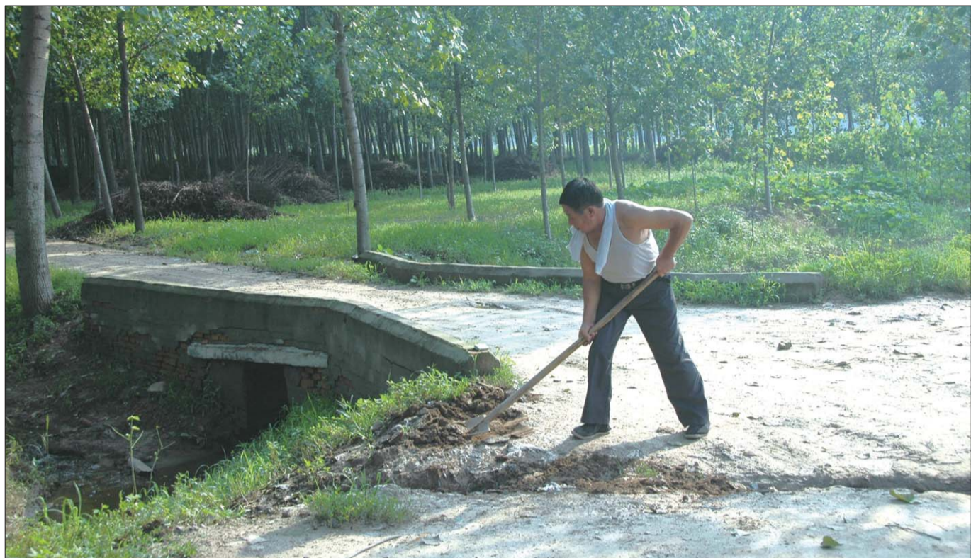
张延成正在修补路面。 本报见习记者 王娟 摄
