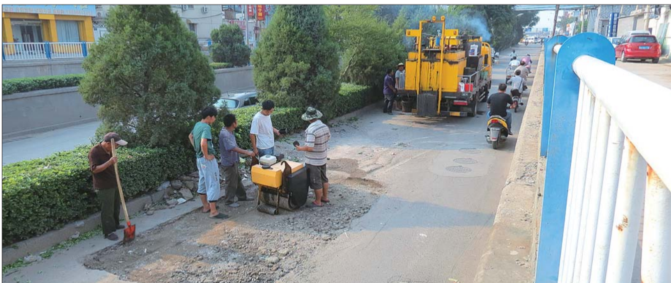
5日下午,大坑已经基本填平,等待铺设沥青。
