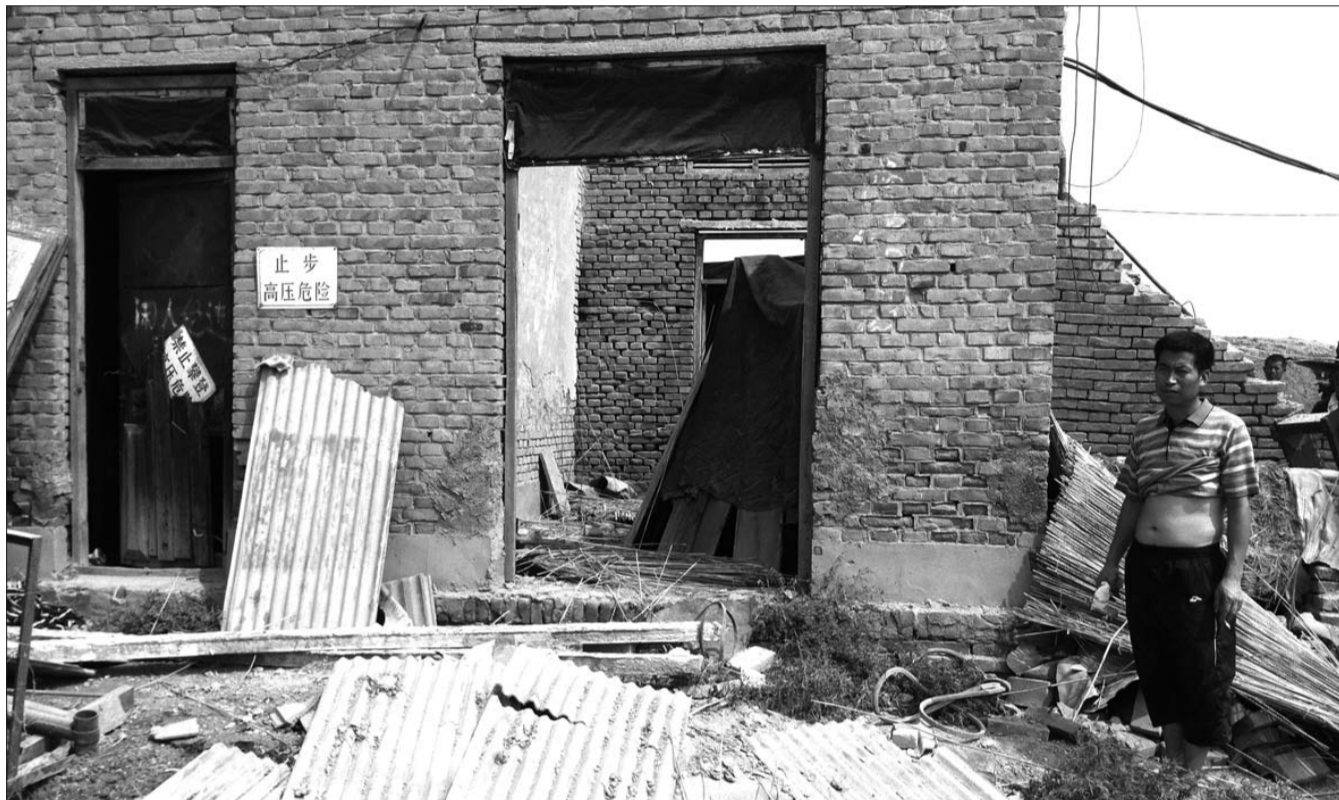
5日凌晨,大风强降雨袭击沾化县,泊头郑家窑厂变压器房屋顶被掀飞,工人只能无奈地看着破损的房屋。本报记者 杨青 通讯员 董丽丽 摄
