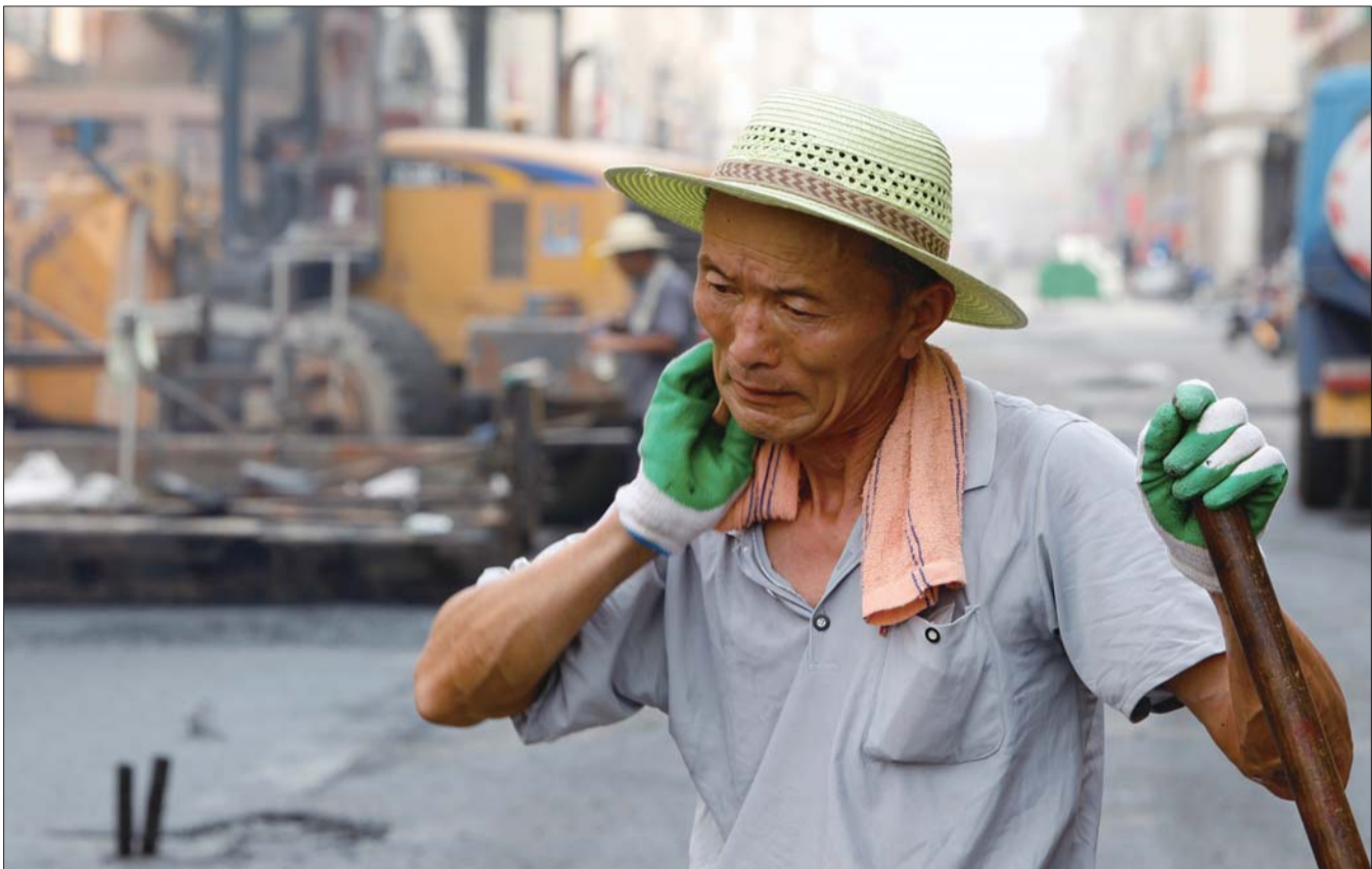
在一个工地施工现场,工人短暂休息。 本报记者 王鑫 摄
