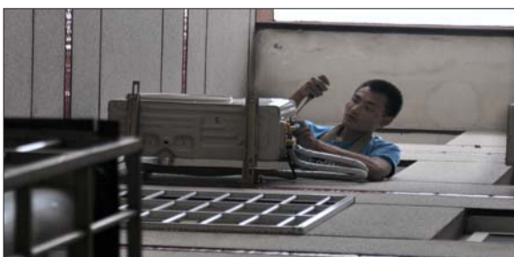
空调安装工师傅固定空调外挂机。 本报记者 王鸿哲 摄
