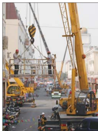
一工地施工现场,工作人员在高温中工作。 本报记者 王鑫 摄
