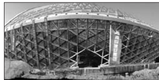
世园会植物园幕墙已铺装完毕。 韩榕 摄
