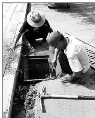
工作人员正在修补井盖。 本报见习记者 王磊 摄
