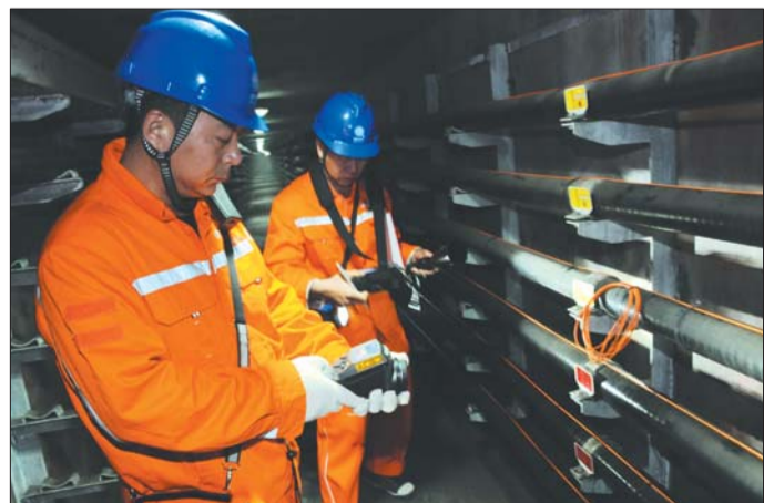
在北海路电缆隧道,工人正对地下电缆进行检测。 本报记者 孙国祥 摄
