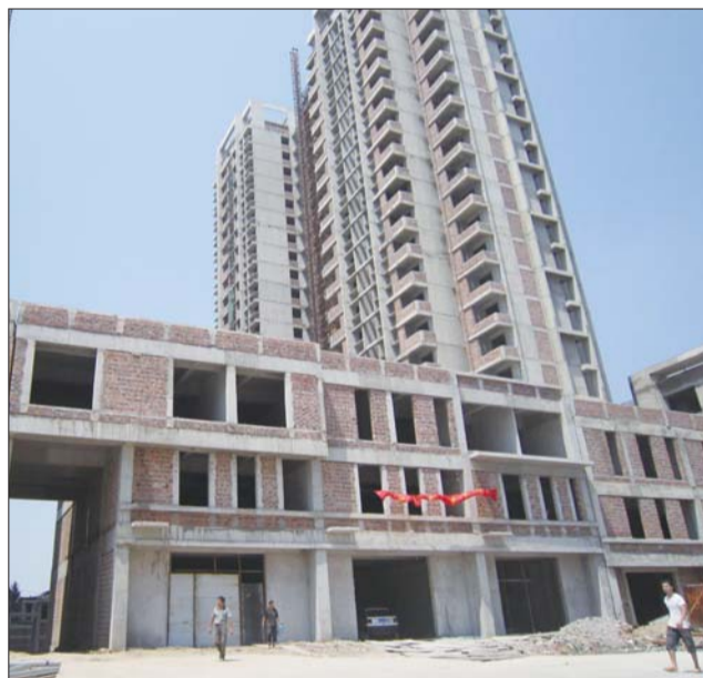
受高温影响,华山路一建筑工地停止露天作业。本报记者 刘婷婷 摄
