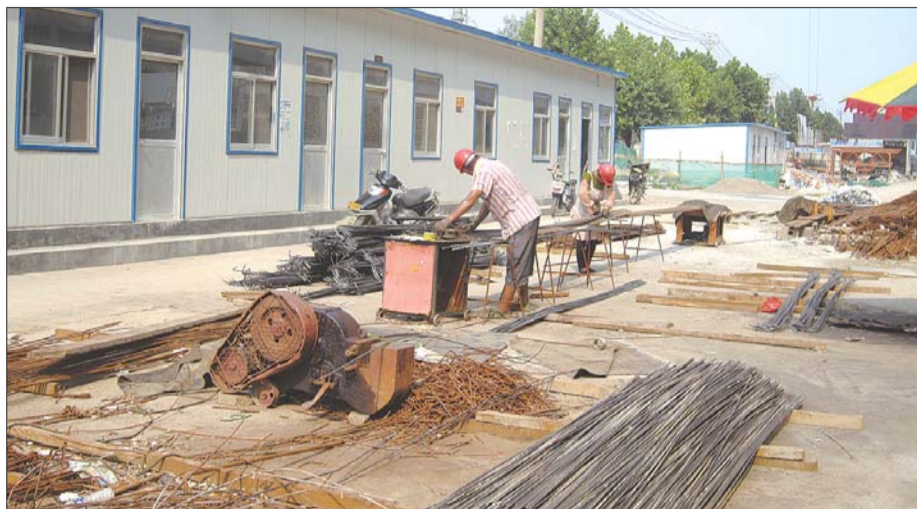
12日,枣庄最高温超36℃,薛城区一工地工人仍在露天作业,被责令停工。本报记者 刘婷婷 摄
