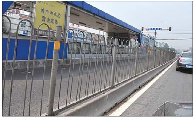
BRT护栏水泥墩占道半米宽,拆除后将使车辆通行能力增强。 本报记者 周青先 摄
