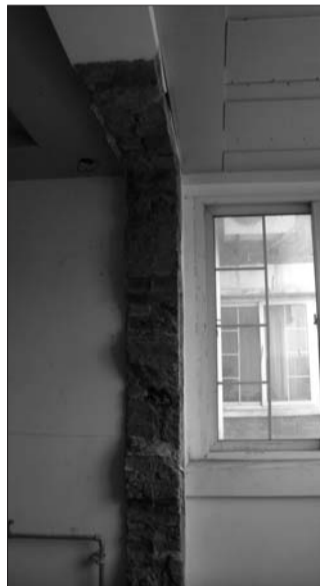
被拆毁的墙面。
