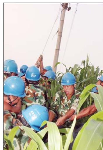
飊线风伴随的雷电，造成平原35千伏楼东线发生接地故障，国网山东平原县供电公司迅速组织抢修人员开展抢修。图为国网山东平原县供电公司员工正在抢修35千伏楼东线。
