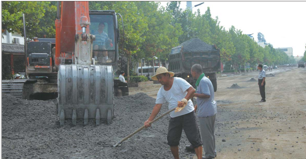
交通局施工人员正在南环东路施工。 本报见习记者 王文彬 摄
