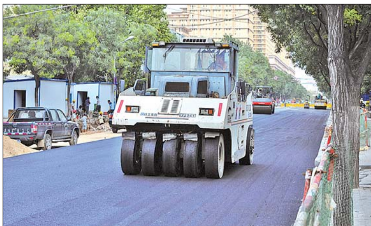
18日,在和平路改造工地,工程人员正铺设沥青。 本报记者 周青先 摄
