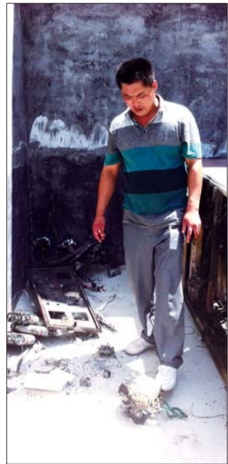
配电器被烧得只剩下了外壳。 高雯 摄
