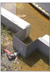
此次事发的位于防护堤处的排水阀
