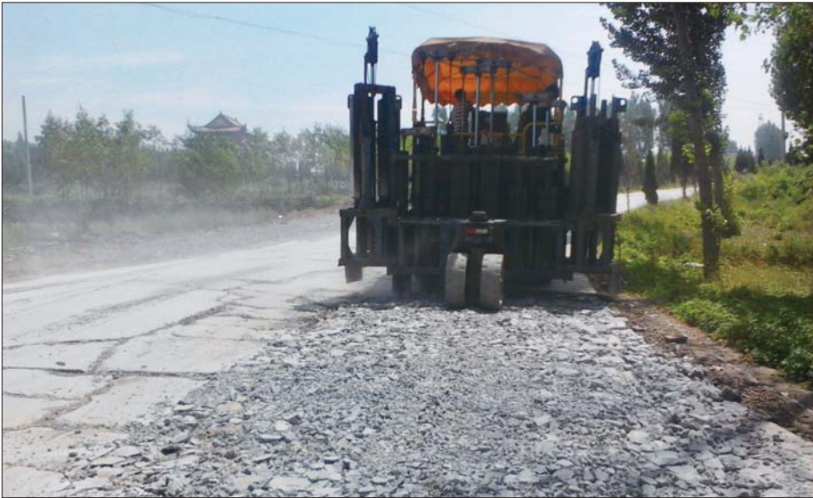
施工人员正在对淄中路损坏严重路段实施路面破碎。
