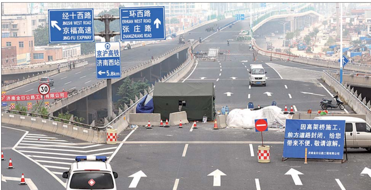
二环西路高架已摊铺完沥青路面。 本报记者 张中 摄
