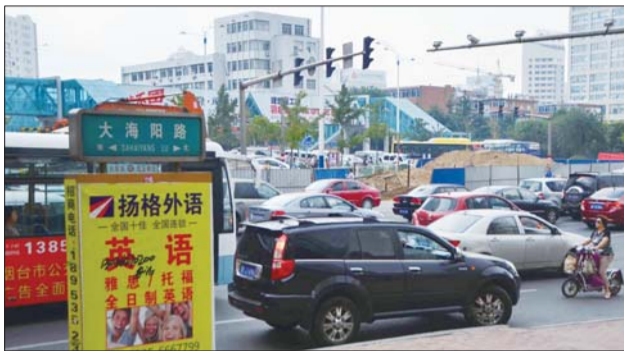
南大街与大海阳交叉口施工,交通拥堵。本报记者 王杰 摄
