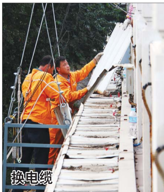
9月10日下午,在东风路岔河桥南侧,工作人员站在桥外侧的架子上拆卸电缆盒,盒内电缆将换新。 本报记者 王小会 摄
