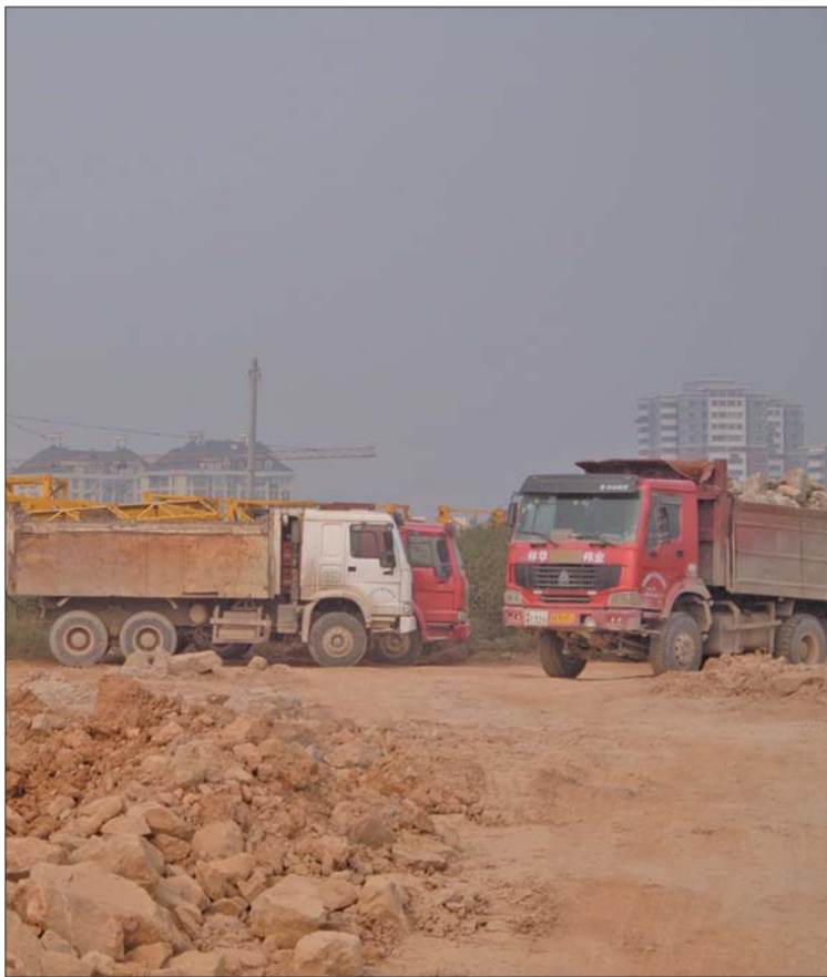
事发工地刚刚开工不久。 本报记者 王兴飞 摄
